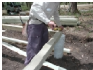
⑤土台がセットできたら、根太の外周に墨打ち。
