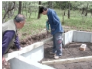
②アンカーボルトの位置に穴を開け土台をセット。
