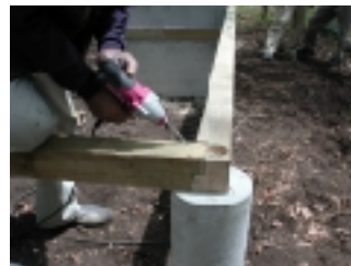
③土台と土台は釘かビスで斜めに止める。
